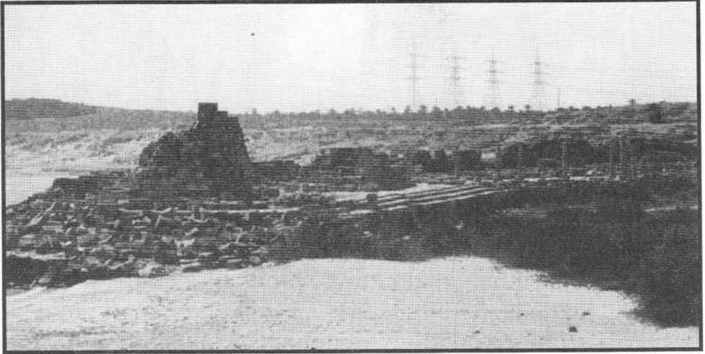
26 ( الأعلى ) : الحاجز الشرقي للأمواج في الميناء بلده المقابل للمدخل المملوء بالطمي . المرجح أن يكون المبنى في الطرف منارة لإعطاء الإشارات لتوجيه السفن إلى للميناء .
